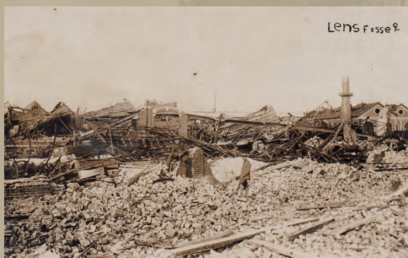
Installations minières détruites à la Fosse 2 de Lens - Collection privée
